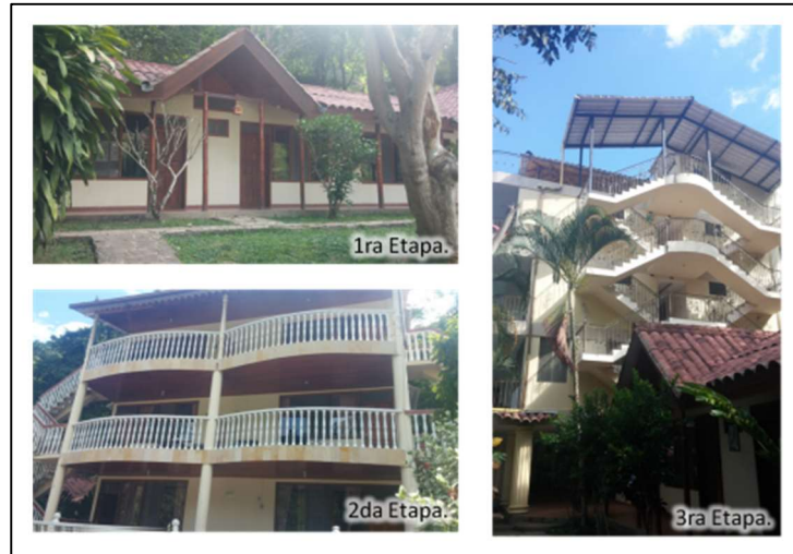
Figura 5. Etapas de construcción Hotel Campestre La Gaitana.
