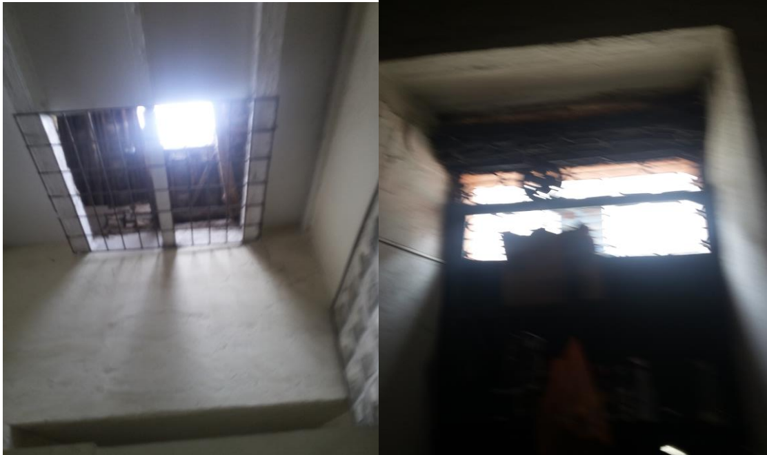
Figura 4 Posibles accesos de plagas al interior de la zona de producción de alimentos.
