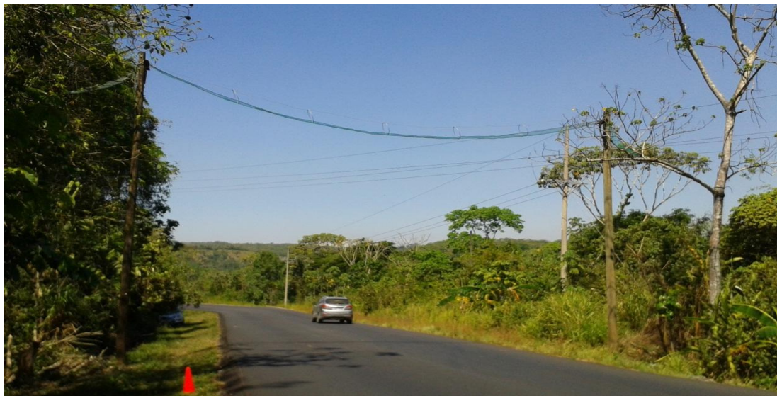
Figura 32. Pasos de fauna arborícola; diferentes diseños colocados y utilizados para el uso de la fauna arborícola (Fuente: ICE y CNFL).
