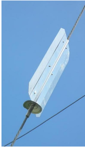
Figura 21. Dispositivo antiescalamiento tipo paleta de 20 X 50 cm, y su diseño. (Fuente: CNFL).
