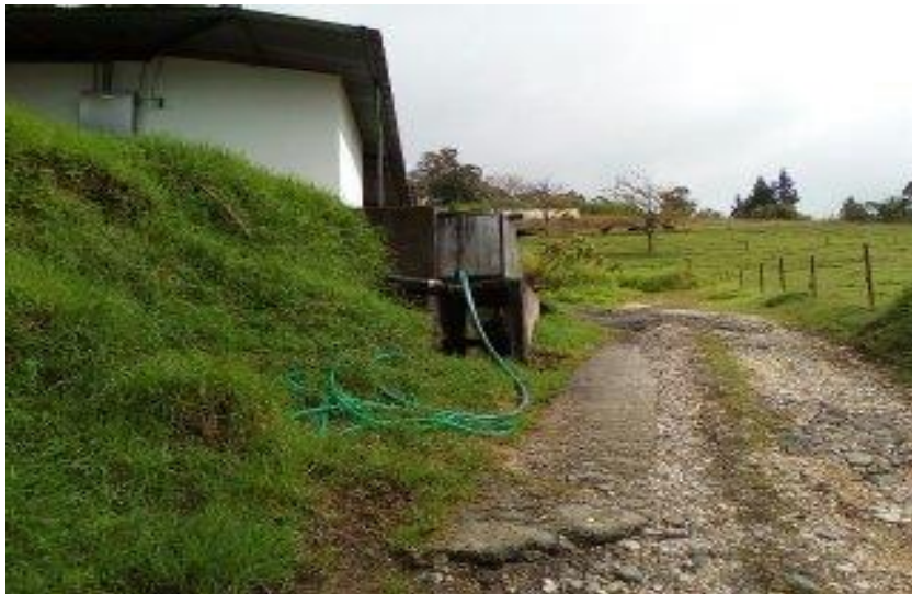
Entrada a la planta
