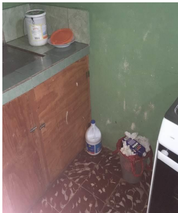
Fotografía 12. Recipiente de residuos sin tapa y producto de limpieza dispuesto en el piso
