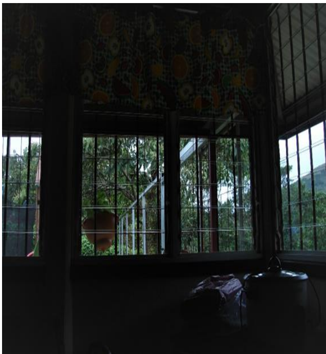
Fotografía 35. Ventanas sin protección
