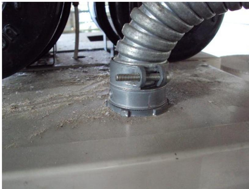
**Figura 13: Condición ambiental: Acumulación de suciedad en algunos sectores de los equipos usados en el proceso.**
