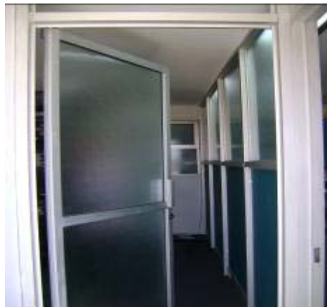
Figura 18: Puerta en el Centro de Datos actual, El Alto
