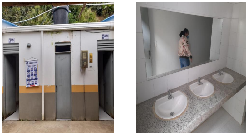
Figura 11. Instalación Sanitaria adecuada
