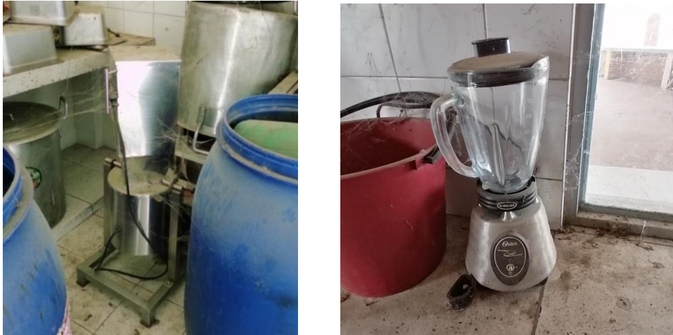
Figura 27. Equipos deteriorados y obsoletos
