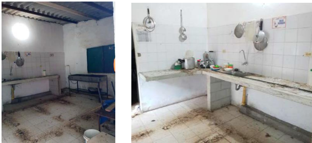
Figura 21. Condiciones de Infraestructura física
