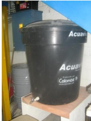
**Figura 7. Sistema de Recolección de Aguas Lluvias**
