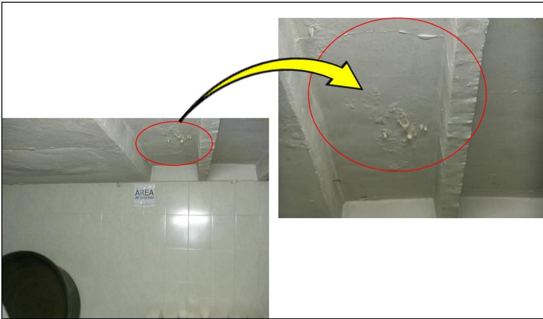
**Figura 10 Condensación en el techo del área de proceso**
