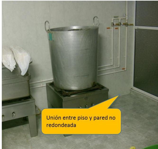
**Figura 13 Condiciones de las paredes y pisos**
