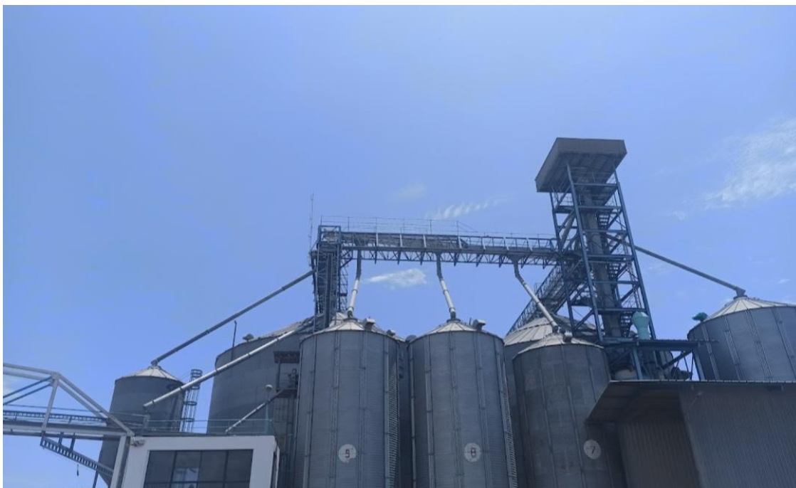
SILOS CÓNICOS CORSUPERIOR S.A
