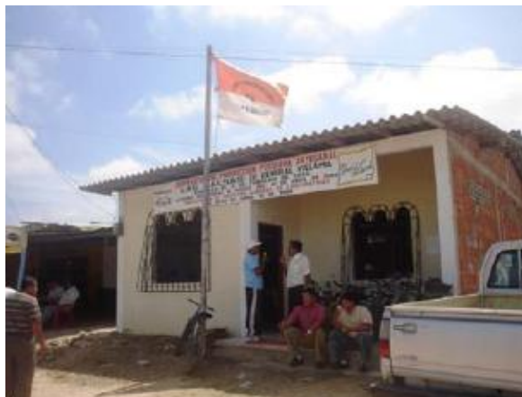
Figura13: Fachada de la Sede social de la Coop. Las Balsas Fuente: Pinos Mariela
