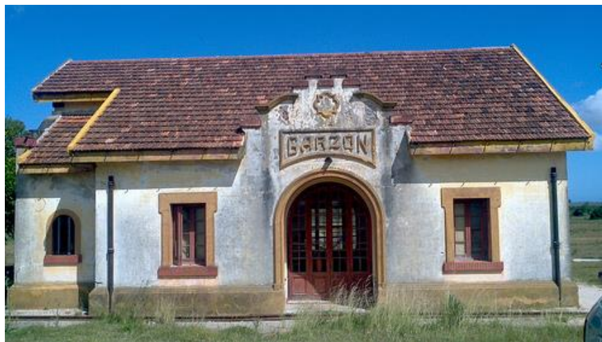
Figura 23- Antigua estación de tren
