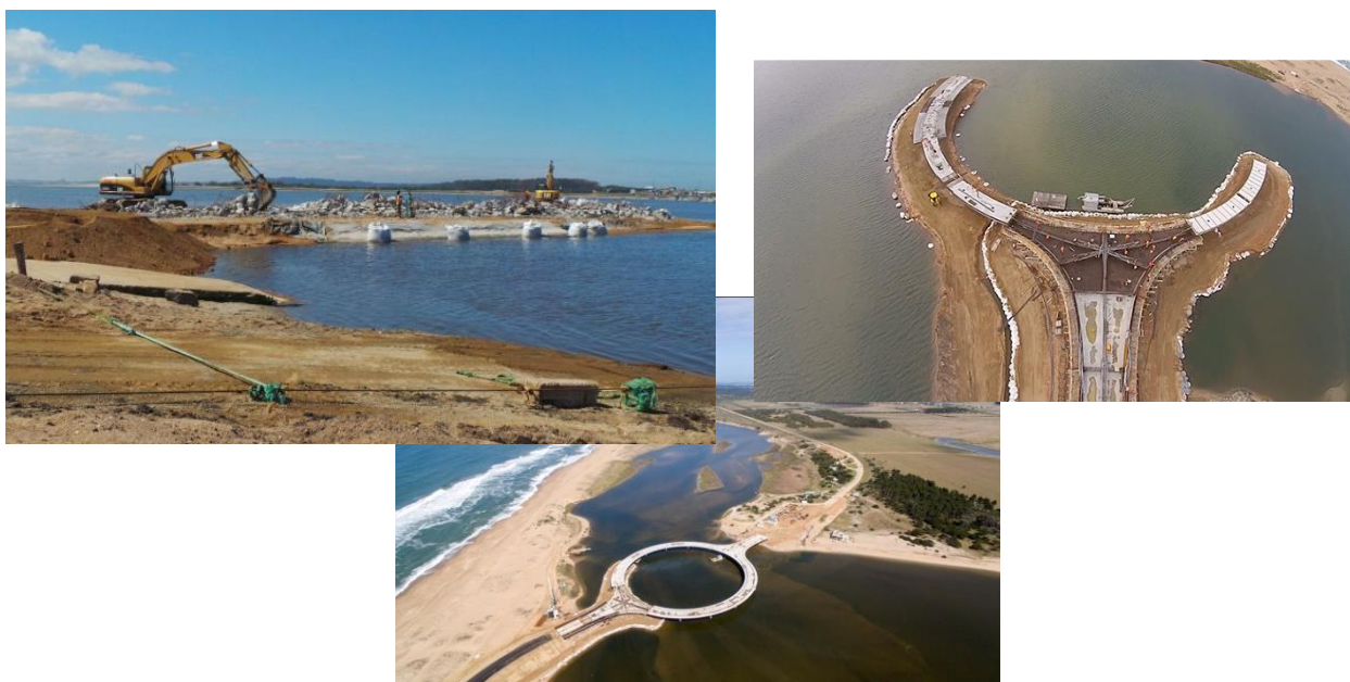
Figura 21- Construcción de puente sobre la Laguna Garzón
