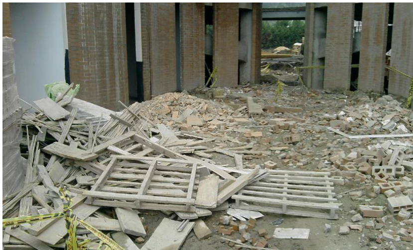
Figura 1. Residuos de Construcción y Demolición - RCD.
