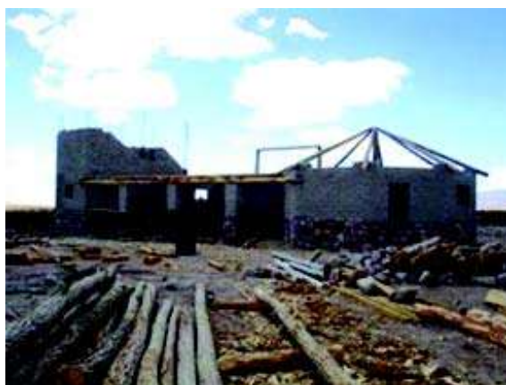
Distintos momentos de la Construcción del Centro de Interpretación.
