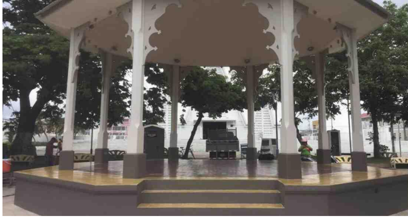
Figura N° 9. Detalle columnas Quiosco Mario Cañas Ruiz. Fuente:
