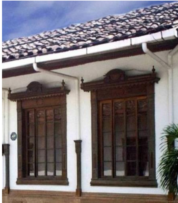
Figura N° 27. Detalle de ventanas de la casa Zúñiga Clachar. Fuente: fotopaises.com
