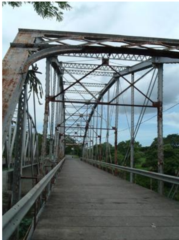
Figura N° 38. Puente La Guardia. Fuente: icomoscr.org
