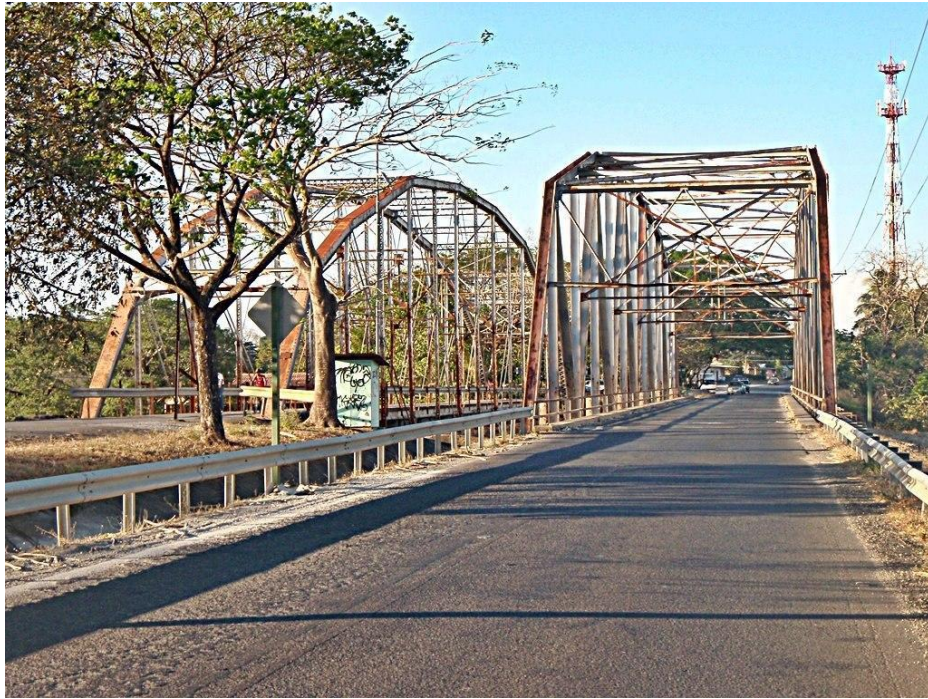
Figura N° 39. Antiguo Puente La Guardia (izquierda), nuevo Puente Tempisque (derecha).
