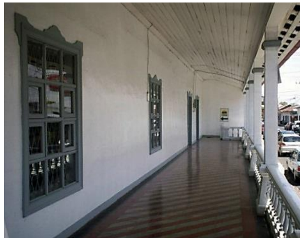
Figura N° 12. Detalle de balaustrada. Fuente: costaricaexplorerguide.com
