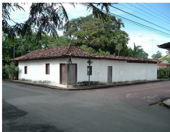
Figura N° 22. Vista “Puerta del Sol” Casa de la Cultura. Fuente: muniberia.go.cr
