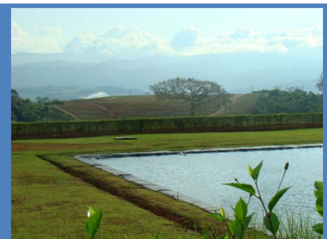
Figura N° 19: Tanque de captación de agua para riego de plantaciones de piña
