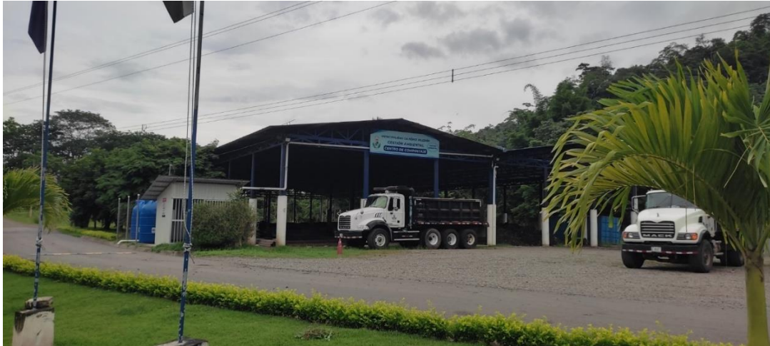
Figura 17. Vista frontal del sitio de compostaje.
