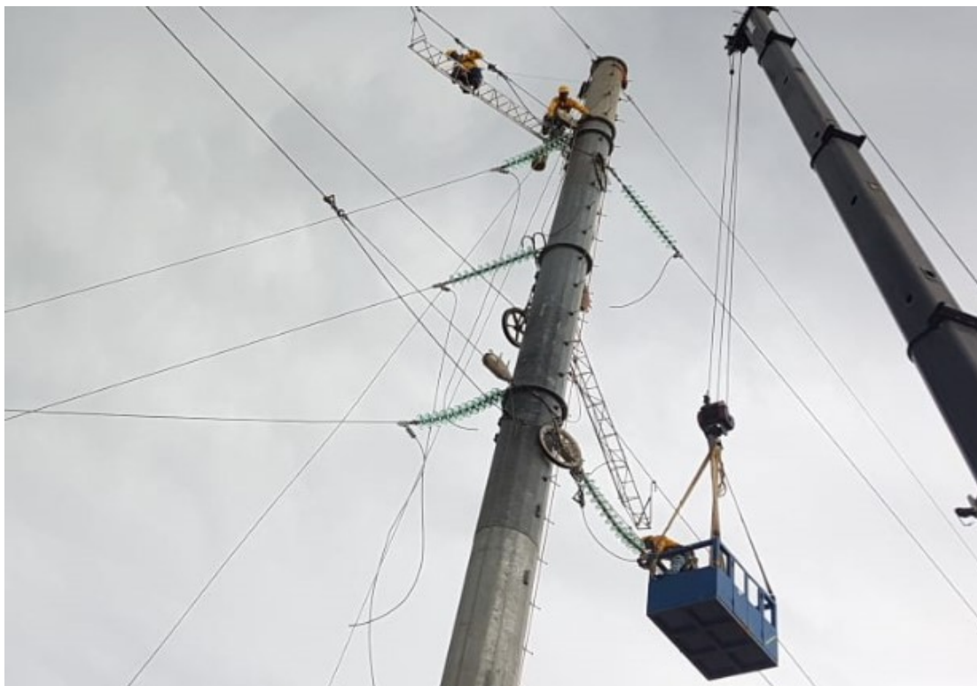
Figura 8. Poste de Alta Tensión (230 kV) de Línea de Transmisión, en etapa constructiva.
