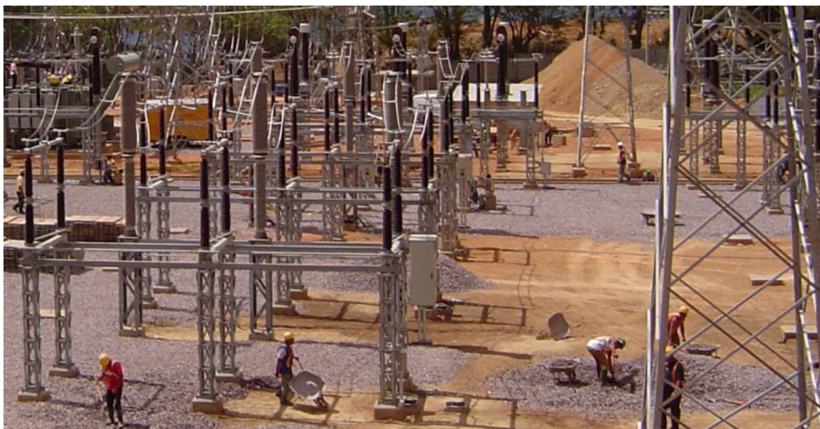
Figura 7. Subestación de Alta Tensión (230 kV), en etapa constructiva.
