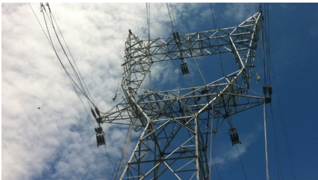
Figura 9. Torre de Alta Tensión (230 kV) de Línea de Transmisión, en etapa constructiva.
