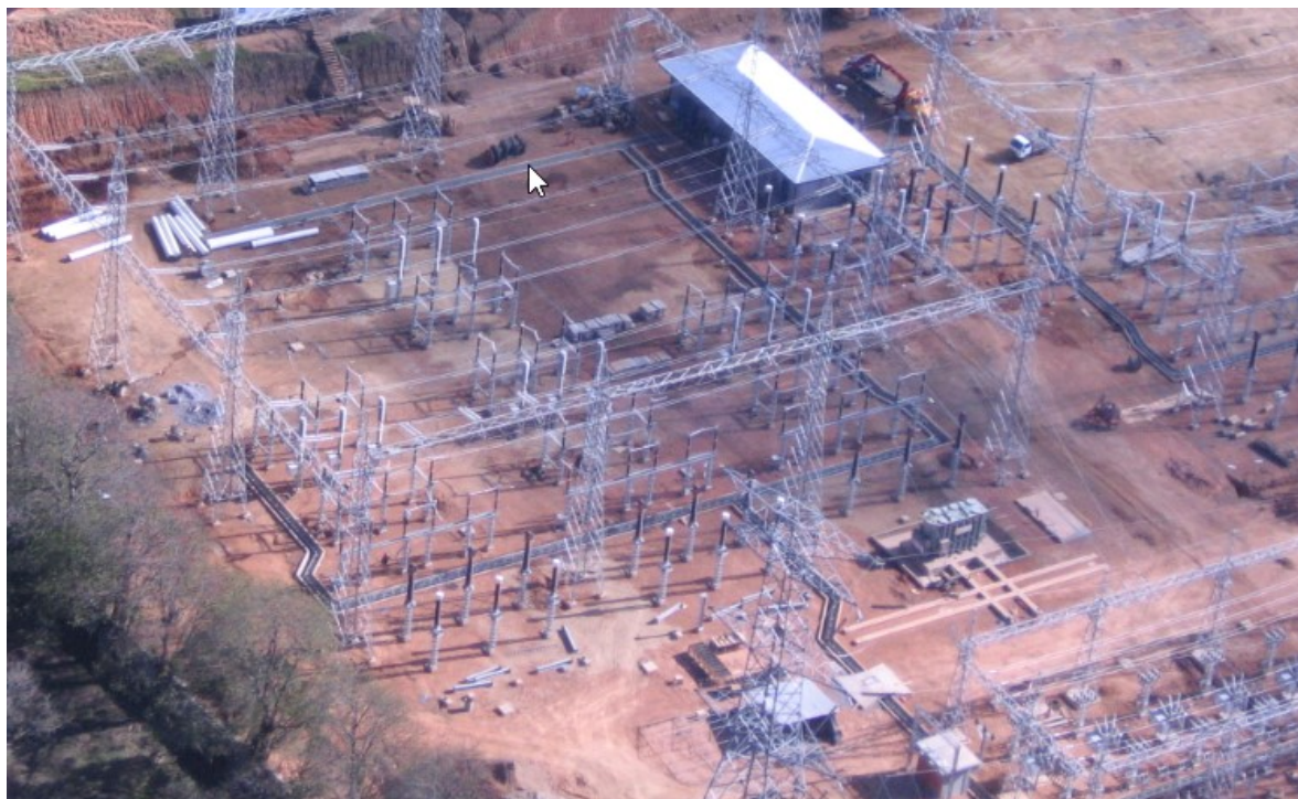
Figura 6. Vista aérea de Subestación de Alta Tensión (230 kV), en etapa constructiva.
