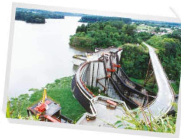
Planta hidroeléctrica Cachi Fuente: ICE
