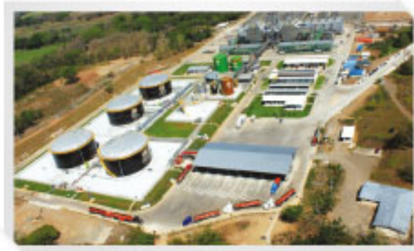
Planta térmica Garabito, Puntarenas Fuente: ICE
