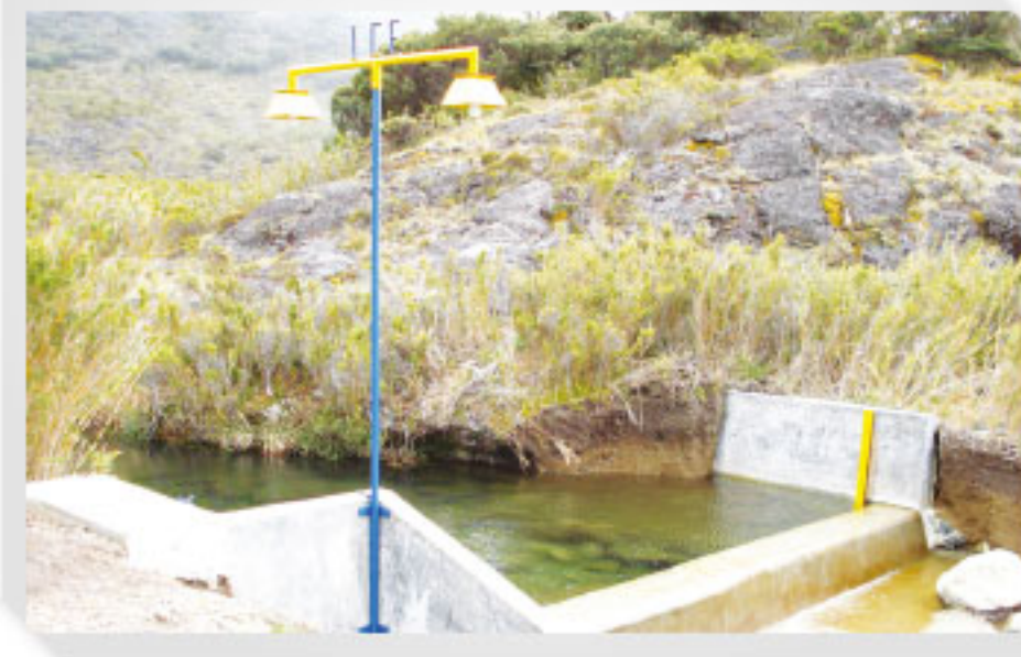
Planta micro hidroeléctrica Chirripó (18 kW)
