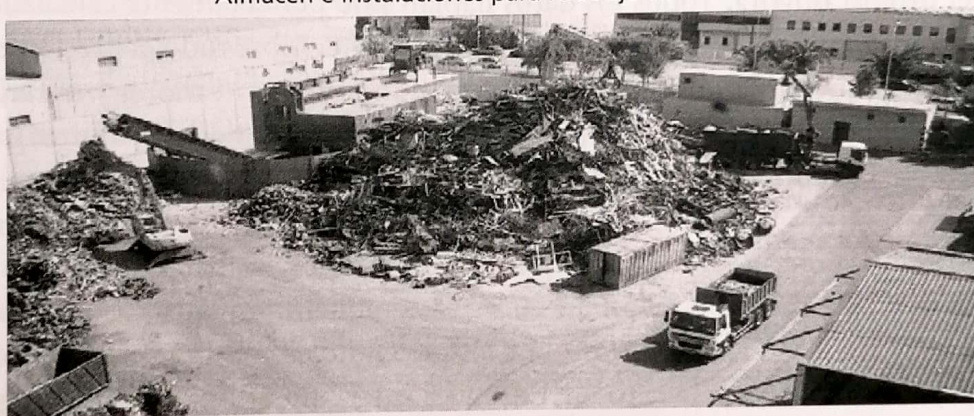
Almacén e instalaciones para reciclaje de chatarra
