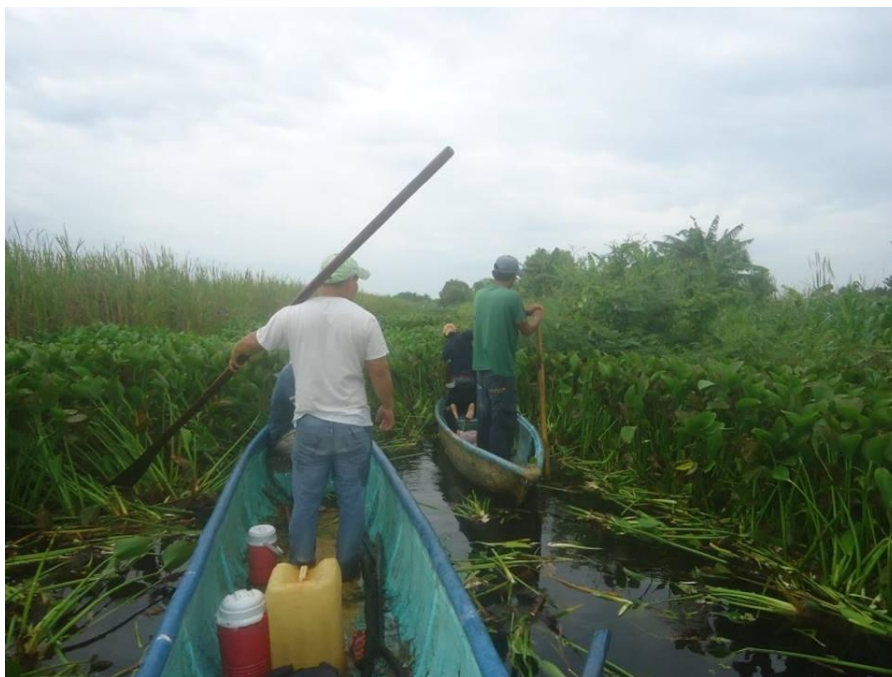
Figura 2 Trabajos Limpieza de canales (Fuente: Ejido Úrsulo Galvan, 2016)
