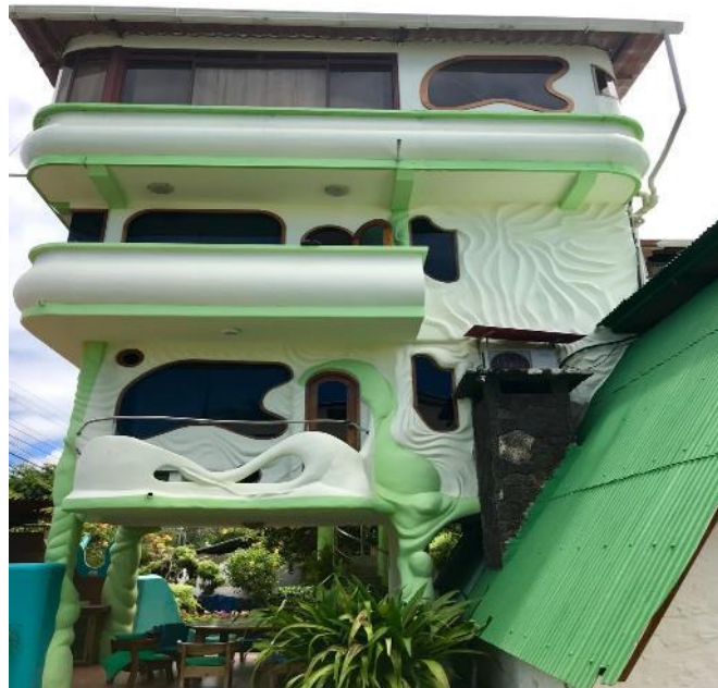
Figura N° 20 Vista Frontal Casa Edén
