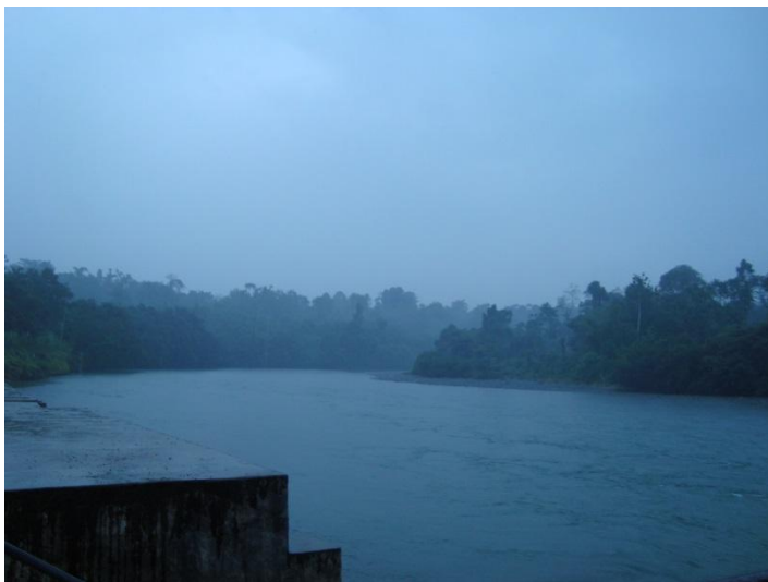
Muro de contención ingreso a Playa de Oro
