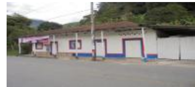
Vivienda Rural Tres Esquinas
