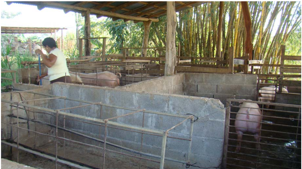
Figura 5. Corral de cerdos sus excrementos es la materia prima para que funcione el biodigestor.
