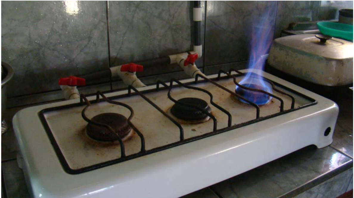
Figura 4. Cocina funcionando con gas suplido por un biodigestor en la comunidad de San Isidro de Cóbano, Puntarenas.
