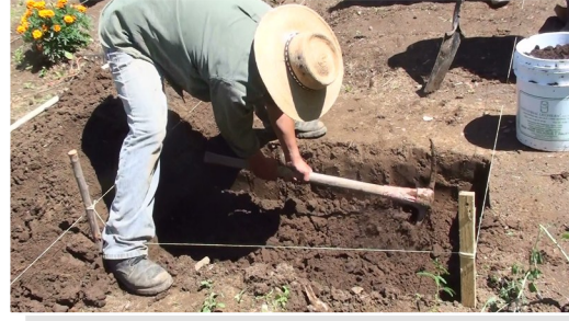
Aflojando el fondo de la zanja
