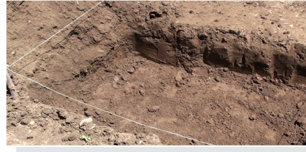
Falta estiércol en esta zanja
