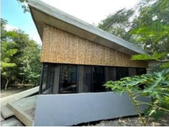
Ilustración 22 Fachada lateral clínica
