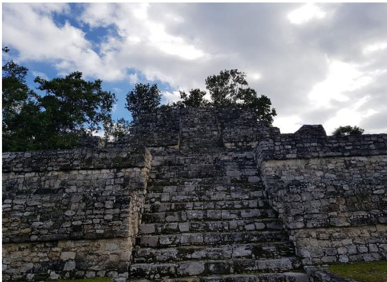
Fotografía 24 Parte superior estructura principal
