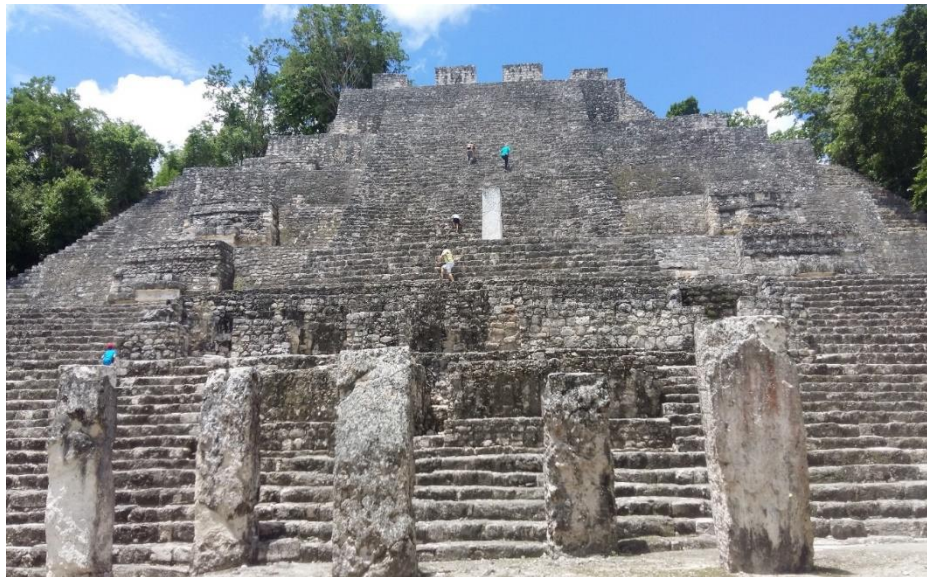
Fotografía 22 Estructura VI, Calakmul.
