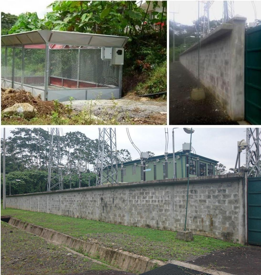
Figura 19. Imágenes ilustrativas de barreras perimetrales ideales para centro de interruptores y subestaciones (Fuente: CNFL).
