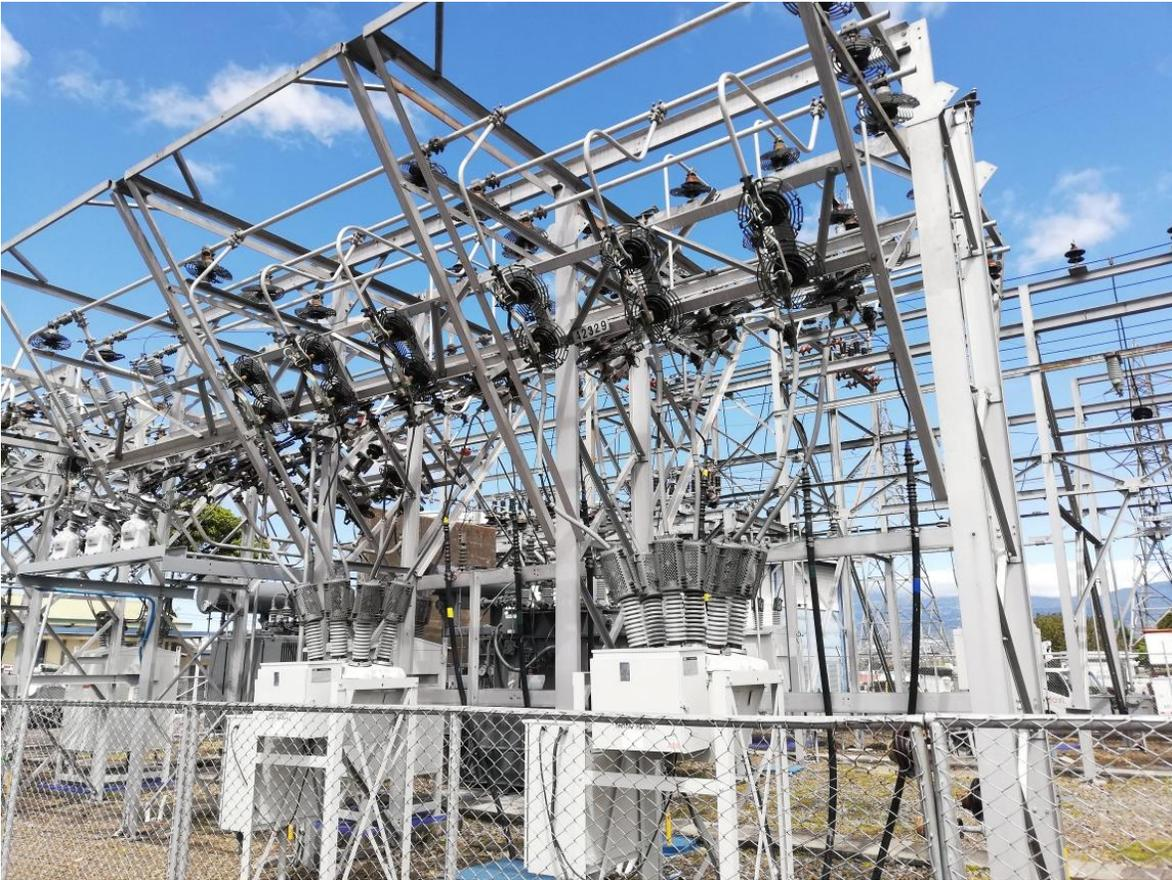
Figura 30 D. Subestación protegida con protectores electrostáticos colocados verticalmente y aisladores. Fuente: ESPH.
