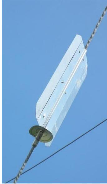
Figura 21. Dispositivo antiescalamiento tipo paleta de 20 X 50 cm, y su diseño.
