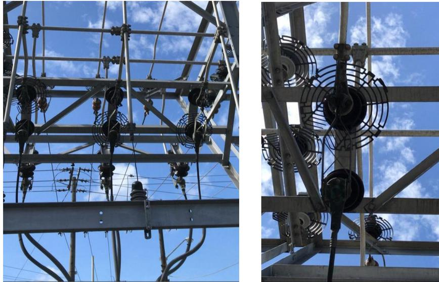
Figura 25. Dispositivos electroestáticos colocados sobre los aisladores de porcelana de los soportes de las cuchillas en una subestación, diseño y forma correcta de colocar (imágenes fuente CNFL)
