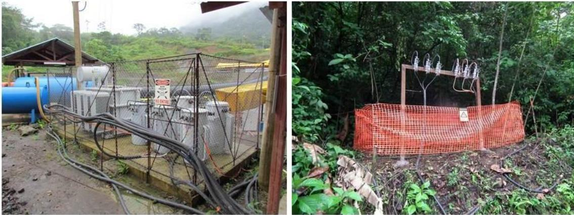
Figura 20. Barreras perimetrales que no contemplan medidas de prevención de electrocución (Fuente: CNFL).
