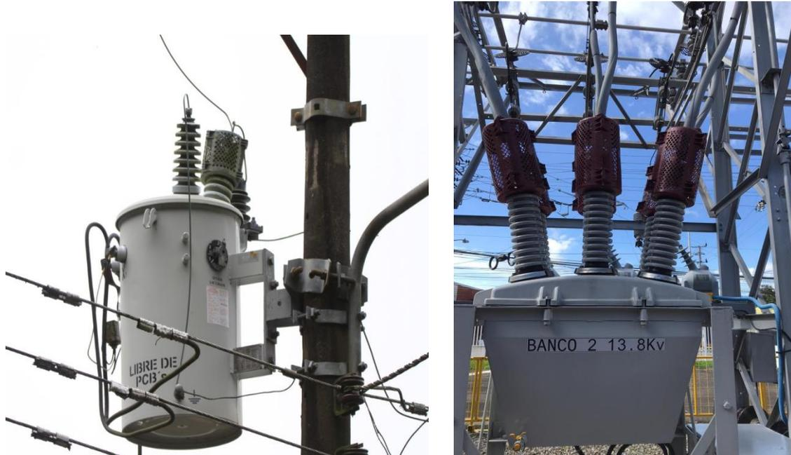
Figura 29 B. Izquierda: protectores de polímero rígido para protección de terminal en transformador (Fuente: ESPH); y a la derecha protector rígido colocados en aisladores de porcelana de interruptores de subestación (Fuente: CNFL).
