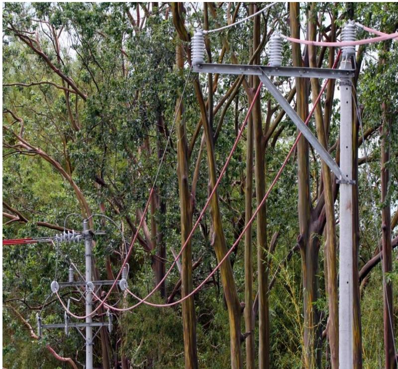
Figura 30. C. Protectores de polímero rígido para el cable (Fuente: ESPH).
