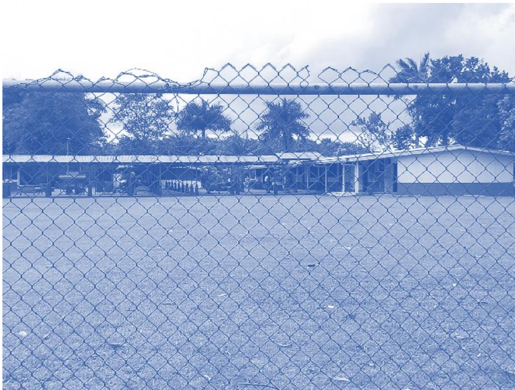
Figura 27: Vista de la Escuela de Cristo Rey
