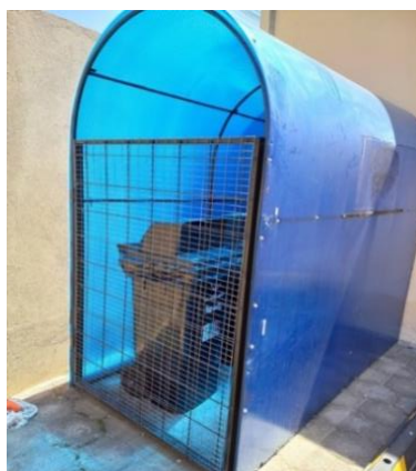
Ilustración 10. Túnel de desinfección adaptado como bodega de desechos finales. Fuente: Autor.
