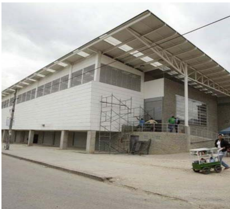
Fotografía 1, Edificio Plataforma Logística Los Luceros. Fuente el Autor
