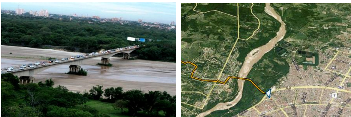
Figuras 26 y 27: Puente Urubó sobre el río Piráí y nuevas urbanizaciones en el Municipio de Porongo.
