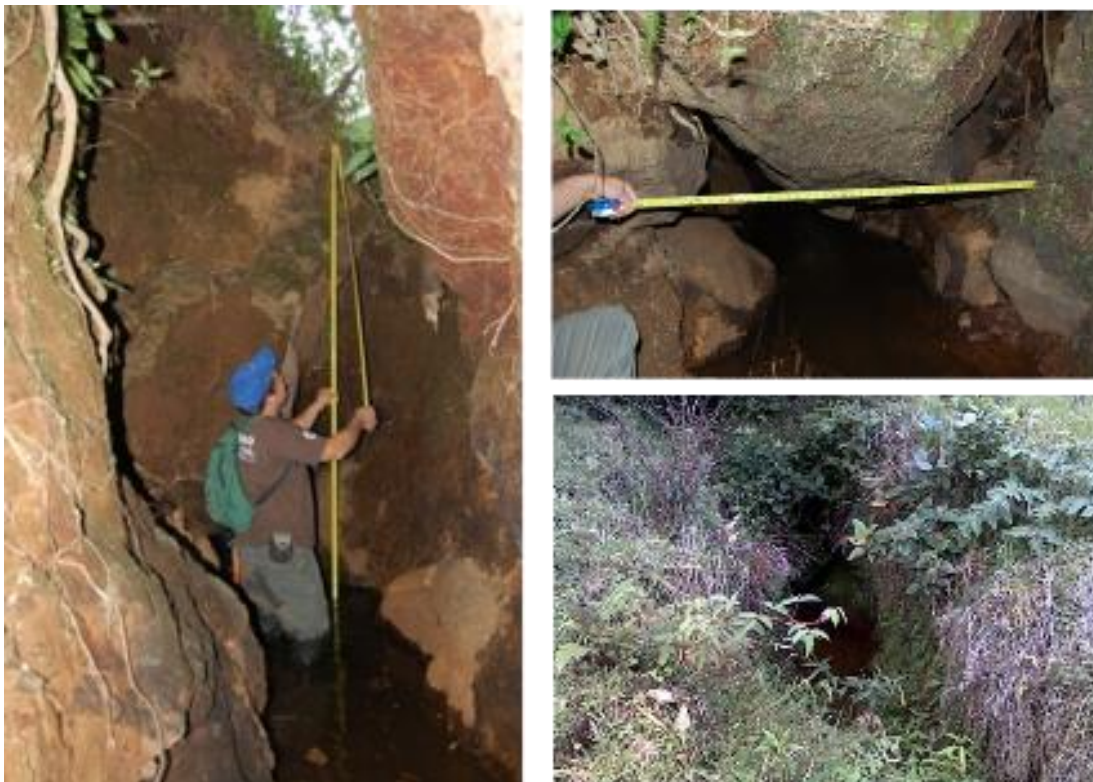
Figura 8: Drenaje Artificial construidos en la Quebrada Rodríguez
