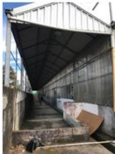
Figura 25. Espacio para ampliar bodega de residuos peligrosos
