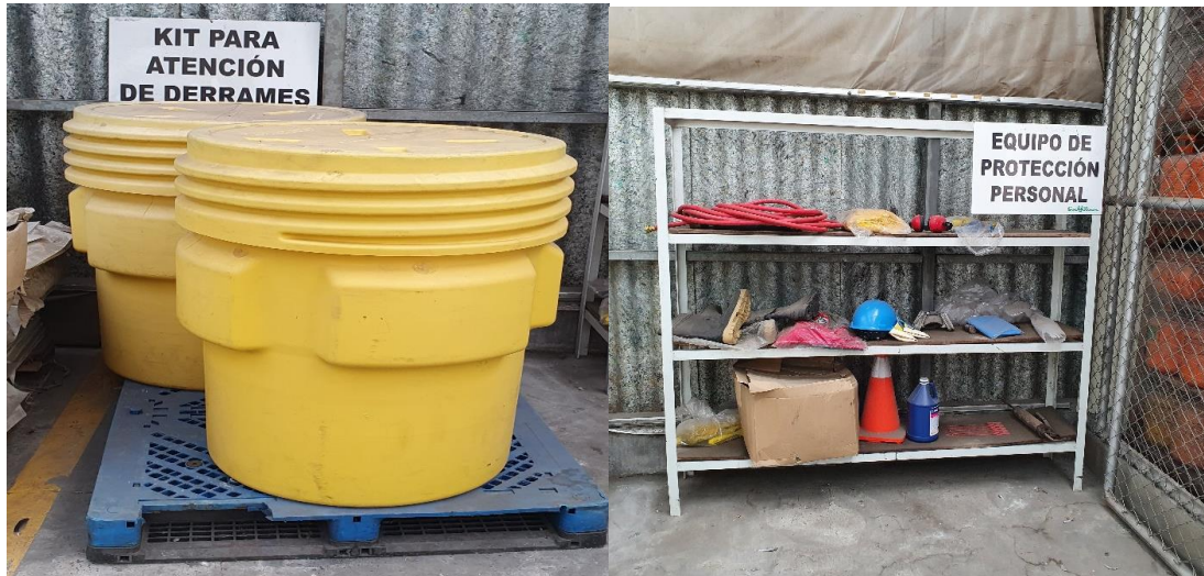
Figura 12. Contenedores de equipo de contención de derrames y equipo de protección personal. Fuente propia.
