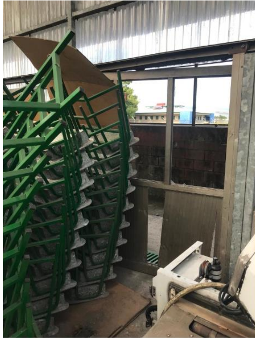
Figura 26. Pueta en mal estado.
