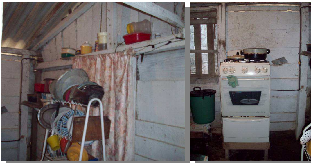
Figura 27: Deficiencias en las condiciones sanitarias en la cocina.
